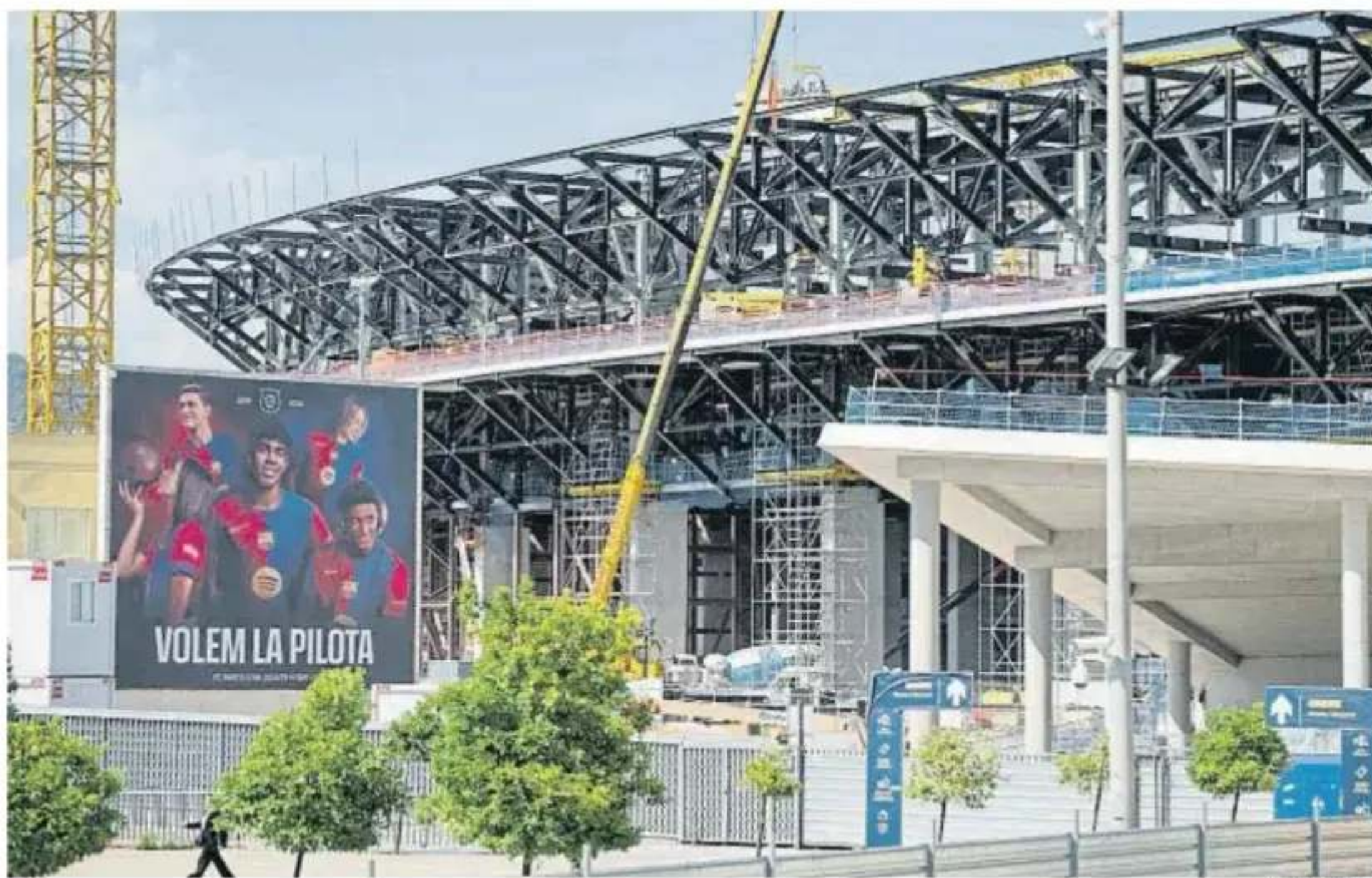
Los operarios de Limak siguen trabajando en turnos de 24 horas para finalizar el primer tramo lo antes posible
