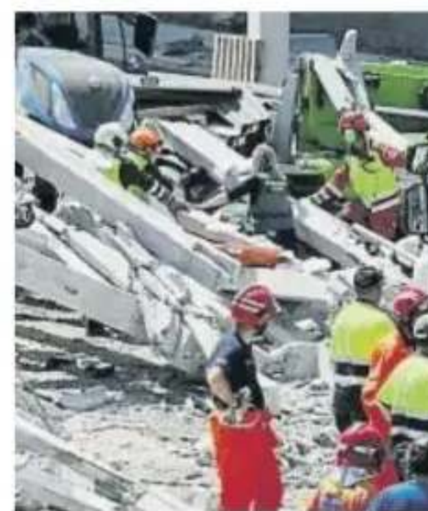
Techumbre de la nave
